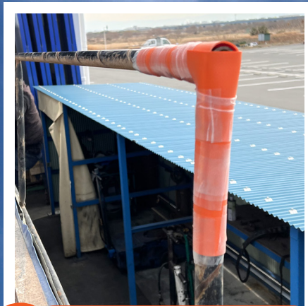
1 枠の角にプロテクタを取り付ける
